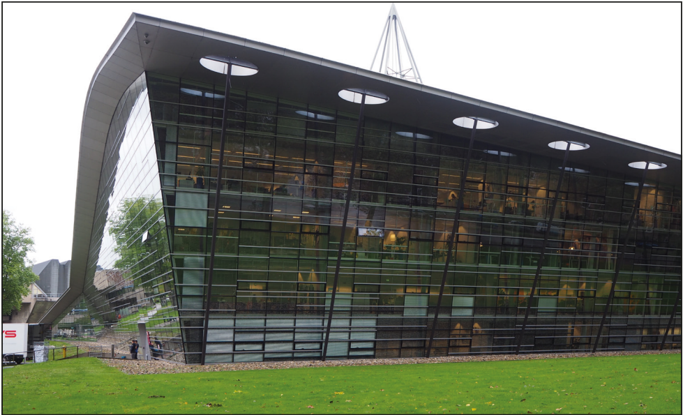
Abb. 20: Bibliothek der TU Delft mit der markanten Spitze des Kegels von der Stadt aus gesehen, Foto: Gemeinsame Baukommission von VDB und dbv
